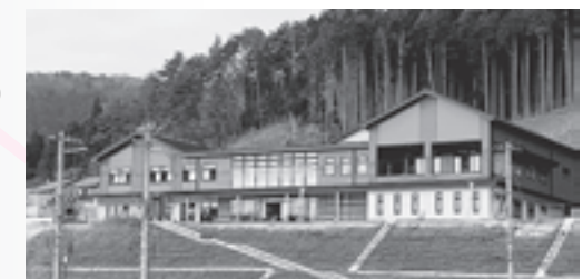
新たな総合支所も もうすぐ完成です♪
