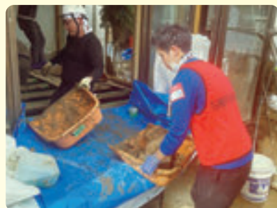
床下に堆積した土砂の運び出し
